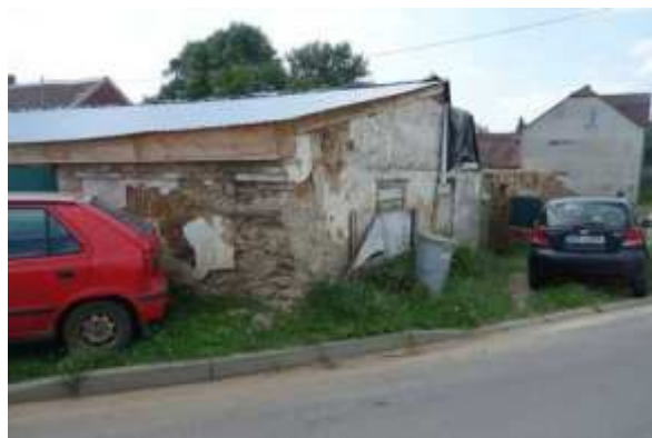
Přístup od komunikace
