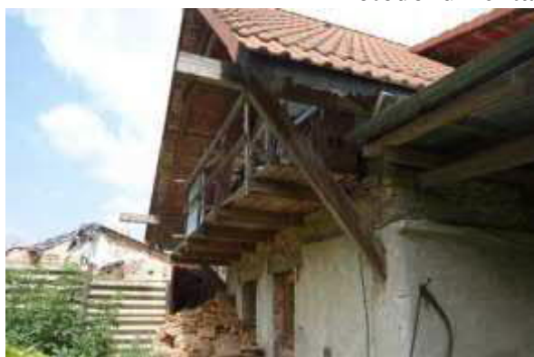
Pohled na RD
