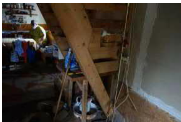
Schodiště do podkroví
