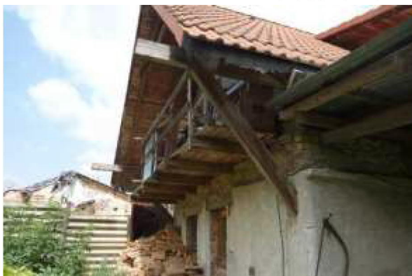
Pohled na RD
